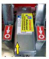
Raccorder le module au réseau cuivre. Mettre le tube dans le raccord, serrer à la main, puis à la clé jusqu'au sertissage. (serrage 1.5 tour max)
